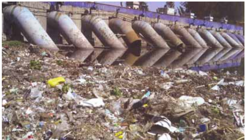
Una de las salidas del drenaje profundo de la Ciudad de México- Foto: La Jornada Especial “Agua”, 2005
