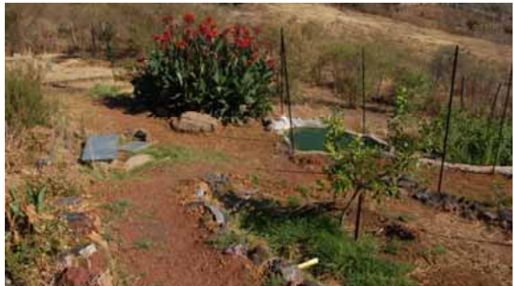
Sistema integrado de tratamiento y reciclaje de aguas grises y negras, incluye biodigestor anaeróbico, humedal artificial, estanque, "drenajes enramados" para reutilizar el agua en el riego de plantas medicinales y árboles frutales (Granja Familiar Tierramor, Junio 2008)
