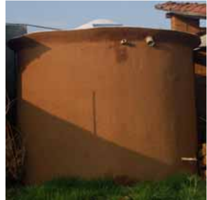
Cisterna elaborada con ferrocemento artesanal - Granja Familiar Tierramor, Erongaricuaru, Michoacán, Junio 2008
