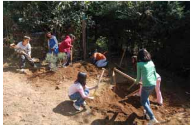
excavación de zanjas de infiltración para proteger una ladera
